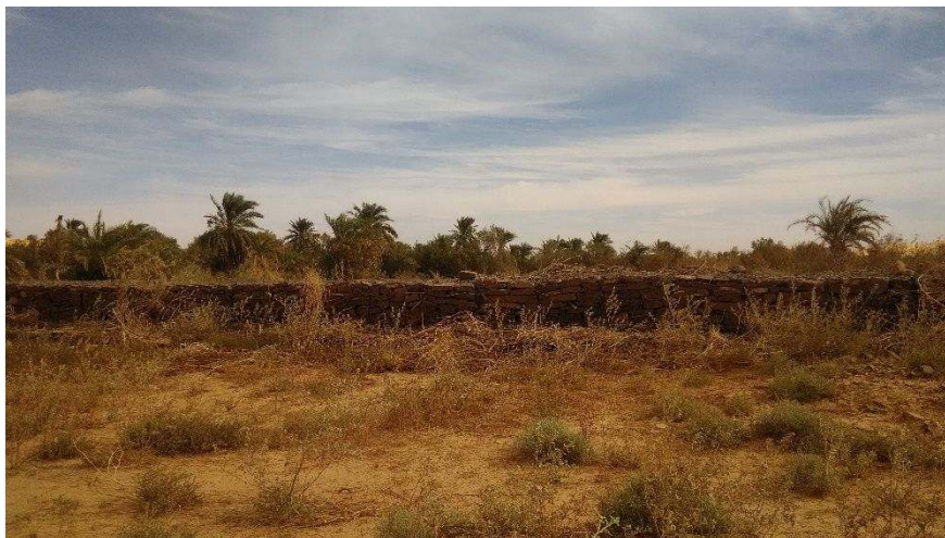
Barrage filtrant au niveau du village
